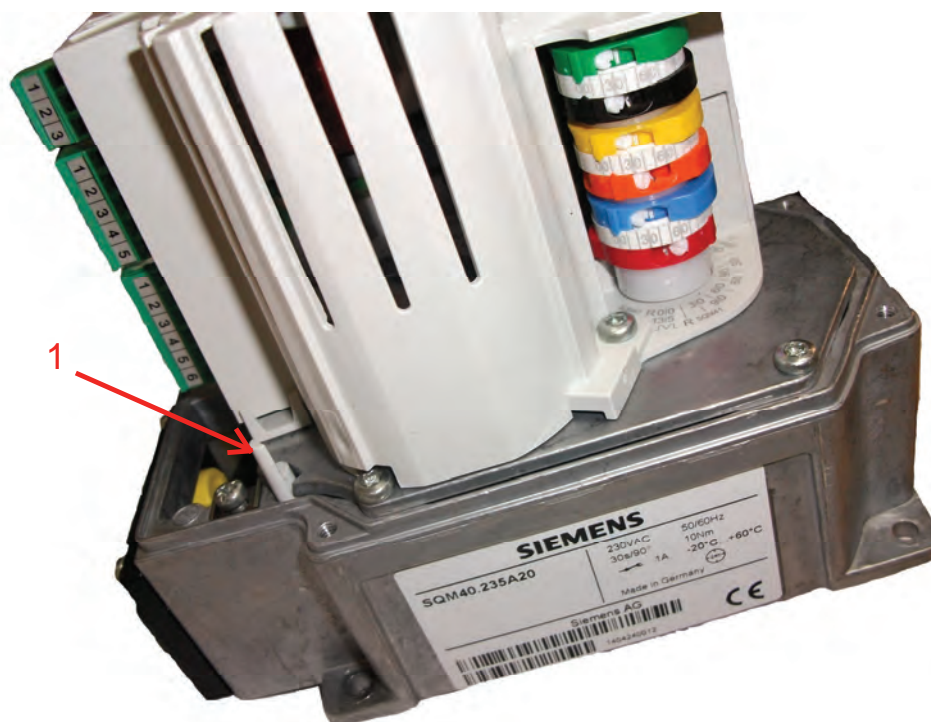
Fig.13 Кнопка освобождения вала
