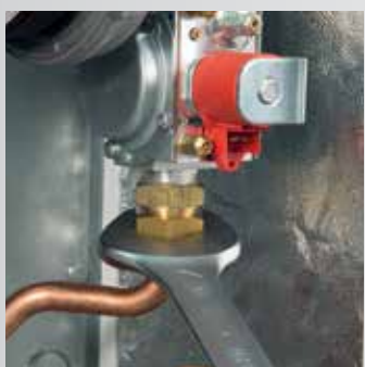
Снятие фиксирующей системы газового клапана
