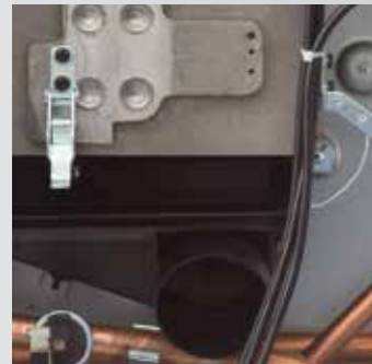
Снятие лотка для сбора конденсата
