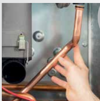
Снятие газовой трубки
