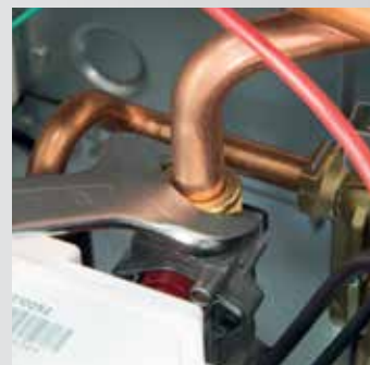
Снятие фиксирующей системы трубопровода
