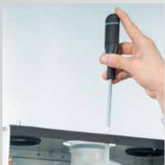
Снятие фиксирующих болтов дымового колпака
