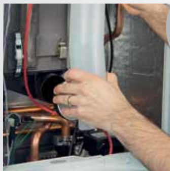
Снятие дымового колпака
