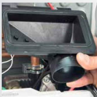
Осмотр лотка для сбора конденсата
