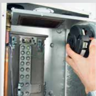
Снятие полной системы сгорания
