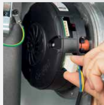
Отключение разъемов вентилятора
