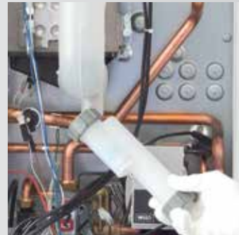
Снять сифон для сбора конденсата
